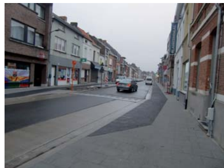
Overgang van fietsuggestiestrook naar vrijliggend fietspad
